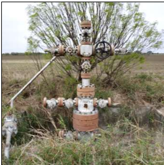
Figura 11. Mantenimiento a conexiones superficiales del Pozo Francisco Cano 62
