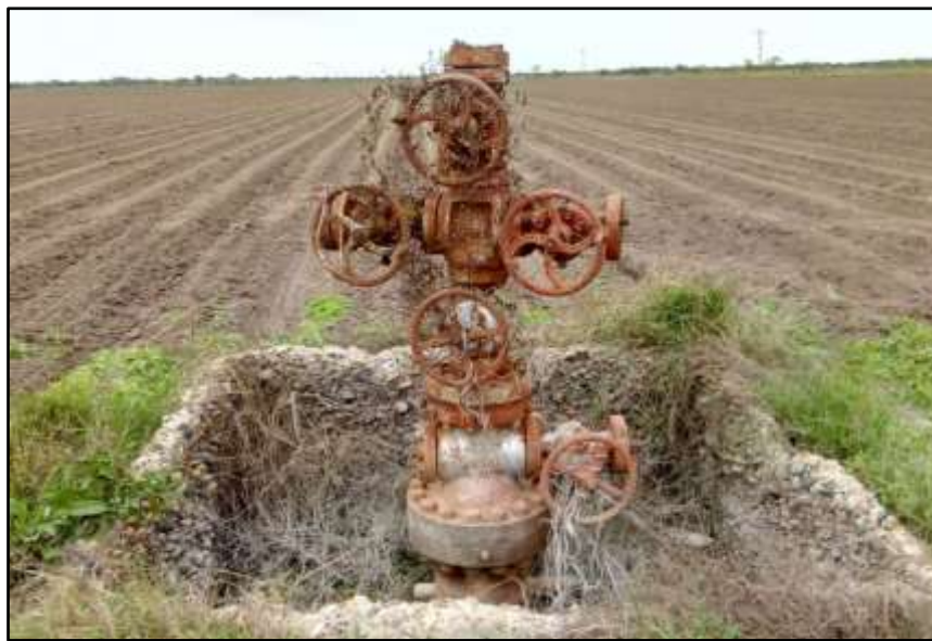
Figura 11. Mantenimiento a conexiones superficiales del Pozo Treviño 201
