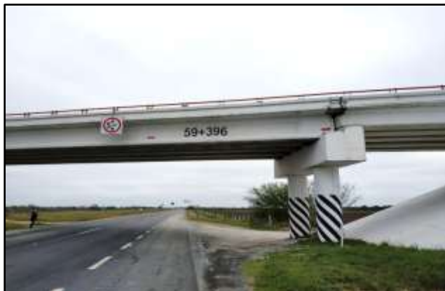
Figura 23. Camino de acceso al Pozo Francisco Cano 24
