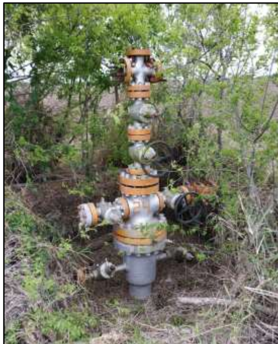
Figura 11. Mantenimiento a conexiones superficiales del Pozo Francisco Cano 24
