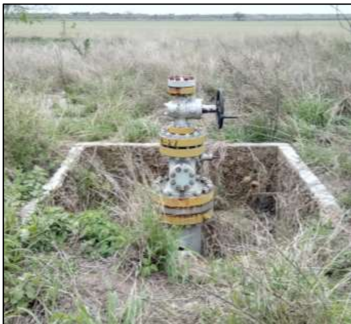
Figura 11. Mantenimiento a conexiones superficiales del Pozo Francisco Cano 27
