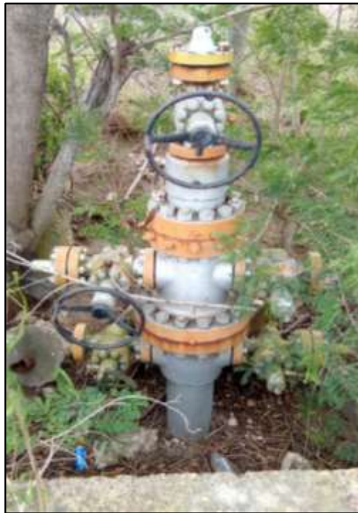
Figura 11. Mantenimiento a conexiones superficiales del Pozo Francisco Cano 67
