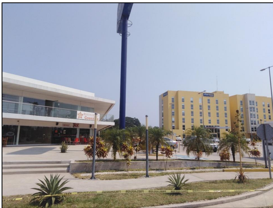
Punto 2 Vista al Sur del terreno del área de proceso de la Refinería Dos Bocas.
