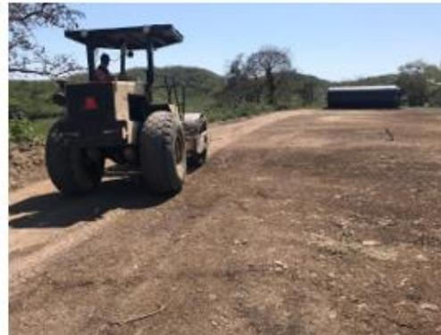
Registro Fotográfico No 5: Conformación, nivelación y compactación de las locaciones de los Pozos 6-A y 8
