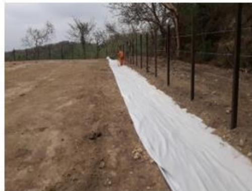
Registro Fotográfico No 6: Construcción de contrapozo del pozo la Laja 11DEL y cunetas con geomembrana para aguas pluviales
