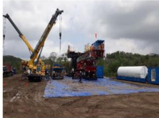
Registro Fotográfico No 10: Armado de equipo de perforación PMX-647
