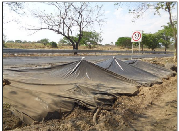
6.- Vista general de la zona afectada por el derrame de Gasolina cubierta con una película de polietileno de alta densidad y con filtros de carbón activado.
