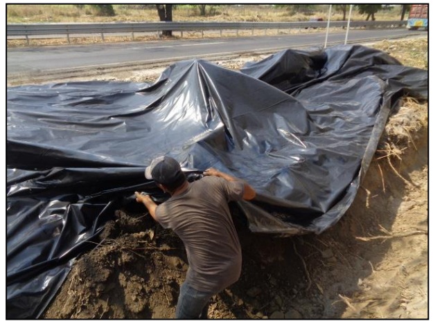
4.- Se cubrió el área afectada con una película de polietileno de alta densidad.
