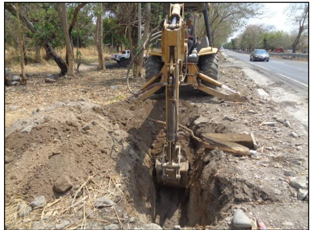
2.- Con apoyo de la retroexcavadora se inicia la construcción de la barrera de contención.
