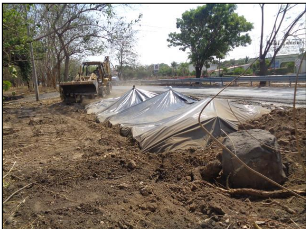
5.- Colocación de filtros de carbón activado.
