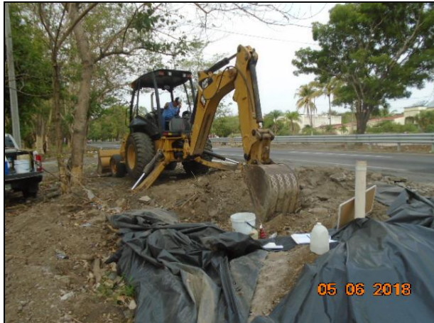
3 – Se utilizó maquinaria pesada como le es la retroexcavadora para lograr las profundidades deseadas.
