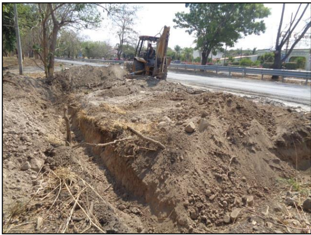
3.- Para evitar el desplazamiento horizontal del contaminante, se construyeron las barreras de contención.
