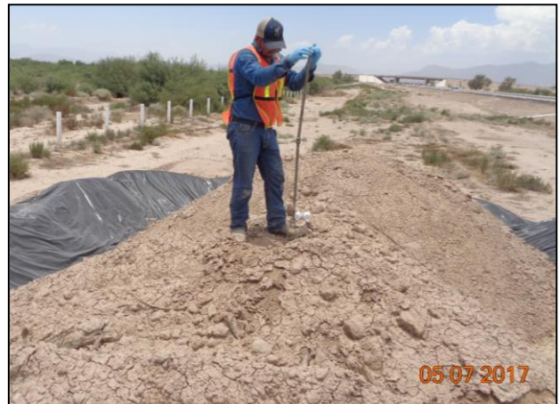
16 – Con ayuda del Hand Auger se tomaron muestras en la celda provisional.
