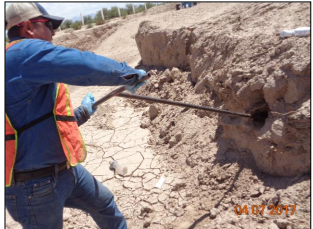
10 – Con ayuda del Hand Auger se tomaron muestras en la pared de la fosa de excavación.
