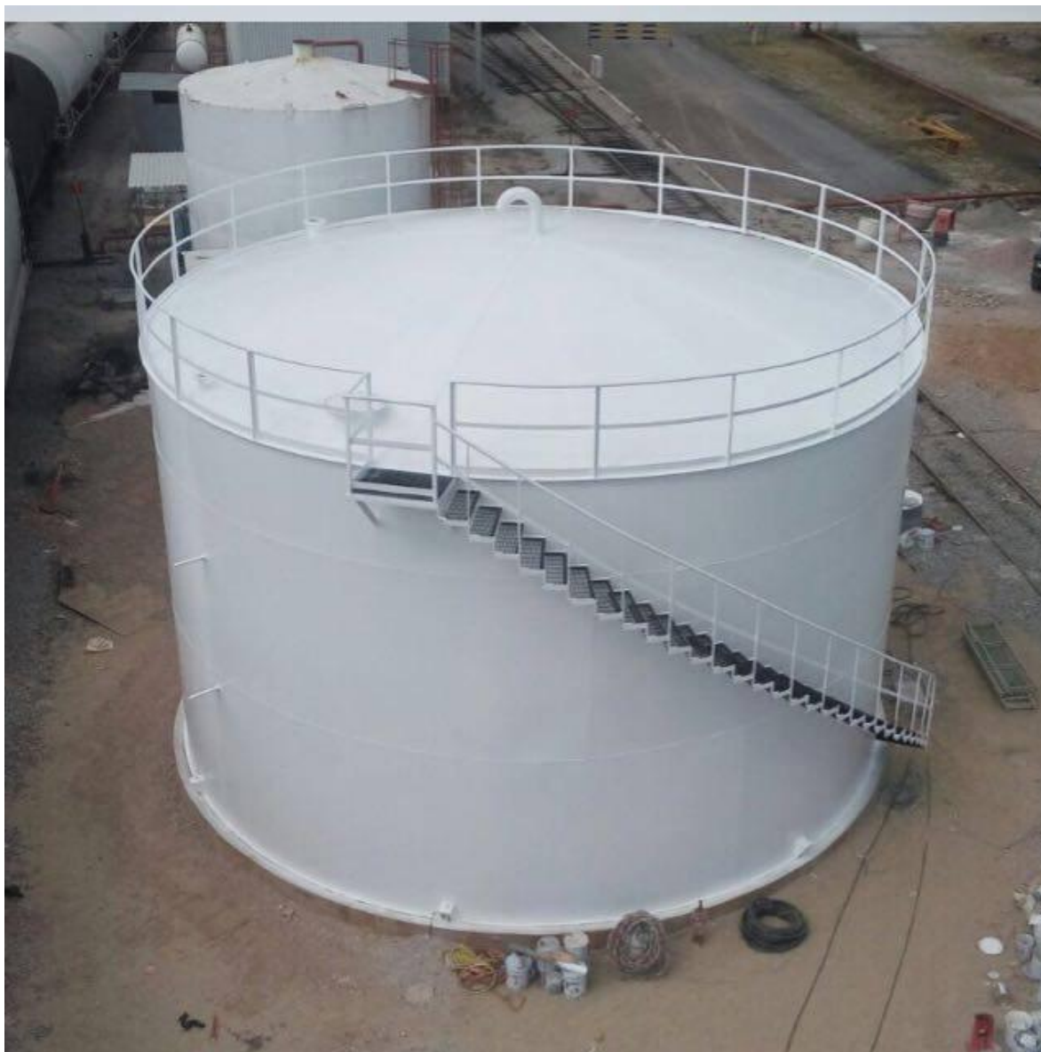
Figura 46. Ejemplo de Tanque de agua para el sistema contra incendios.
