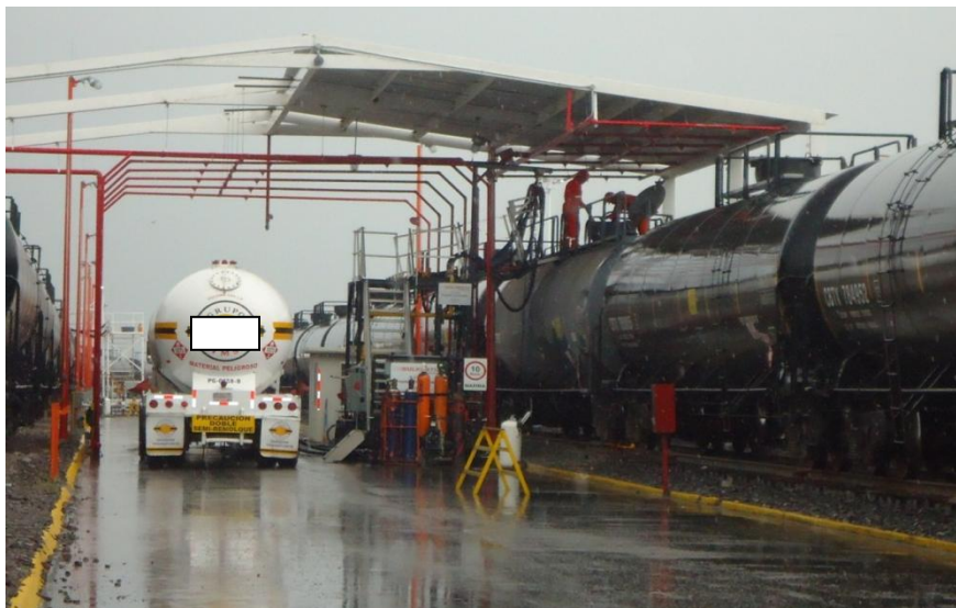
Figuras 29. Ejemplo de Área de Trasvase de Gas L.P.
