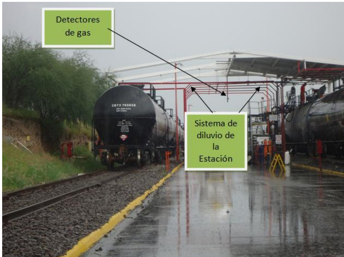
Figuras 32. Ejemplo de Estación equipada para trasvase de combustibles líquidos.
