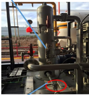
Figuras 27. Conexiones de Transloader a CT y Pipa.
