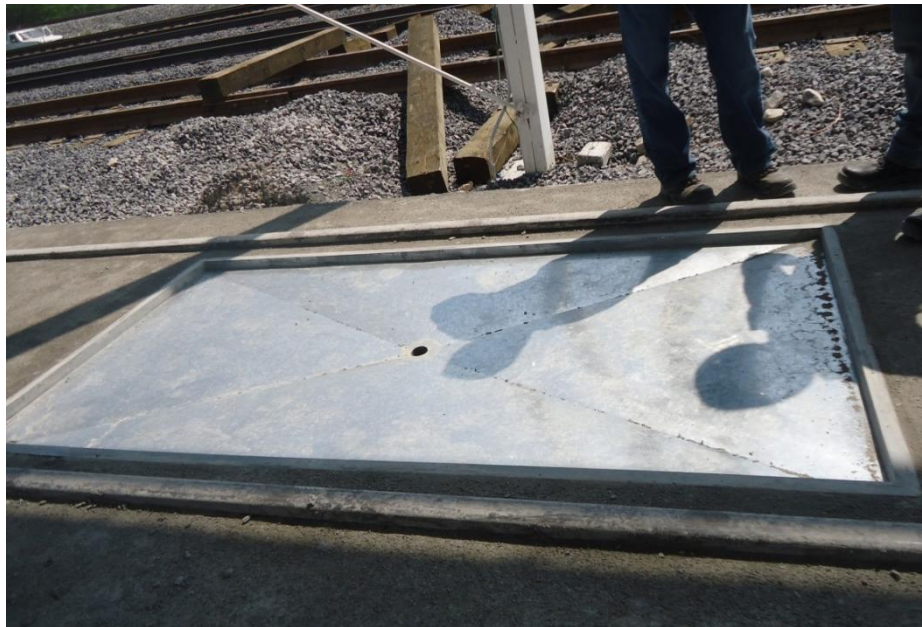
Figura 47. Charola fija para derrames en estación de trasvase de diésel y gasolina.
