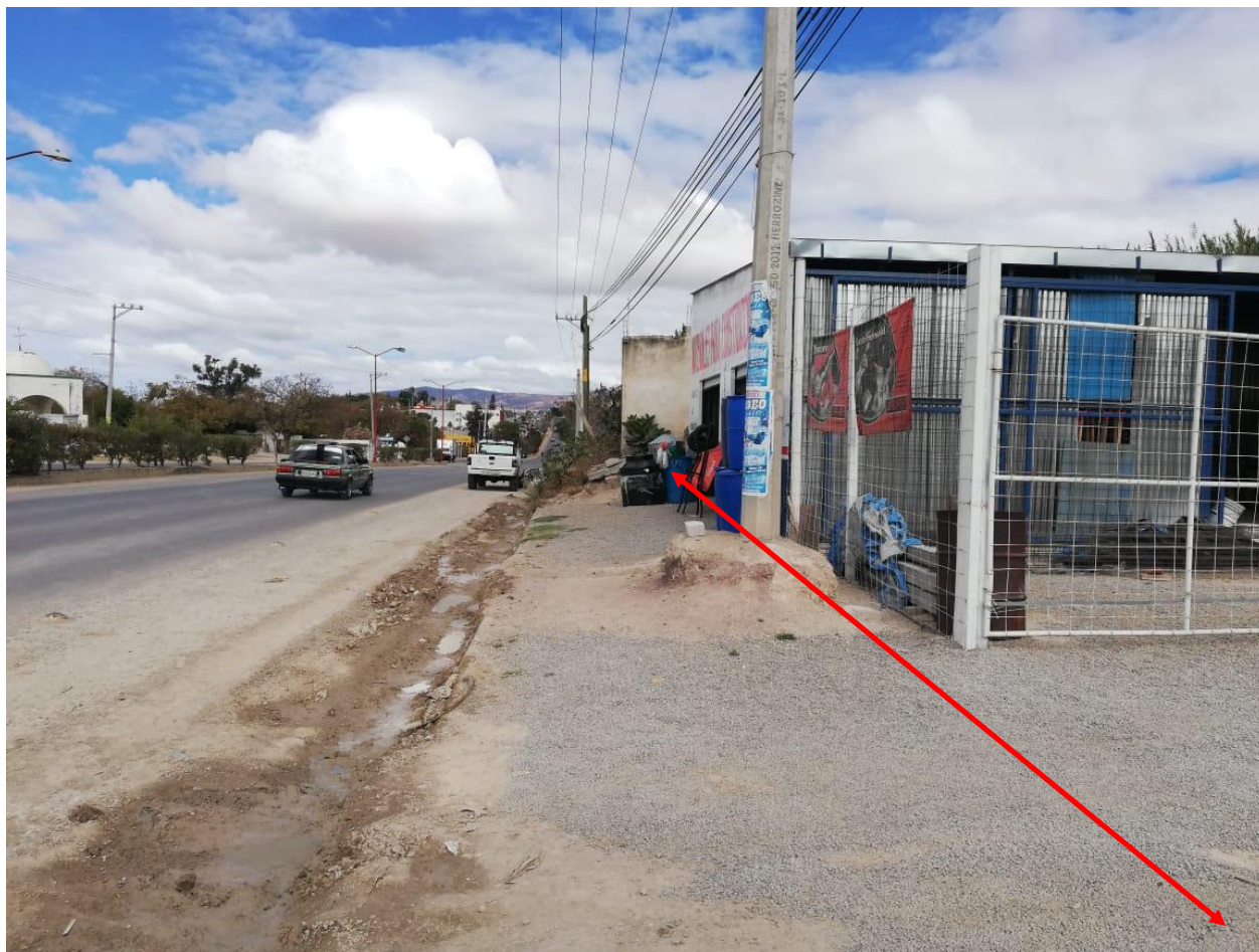
Fotografías 2.- El predio está cercado en su totalidad con muro de concreto y malla electrosoldada.
