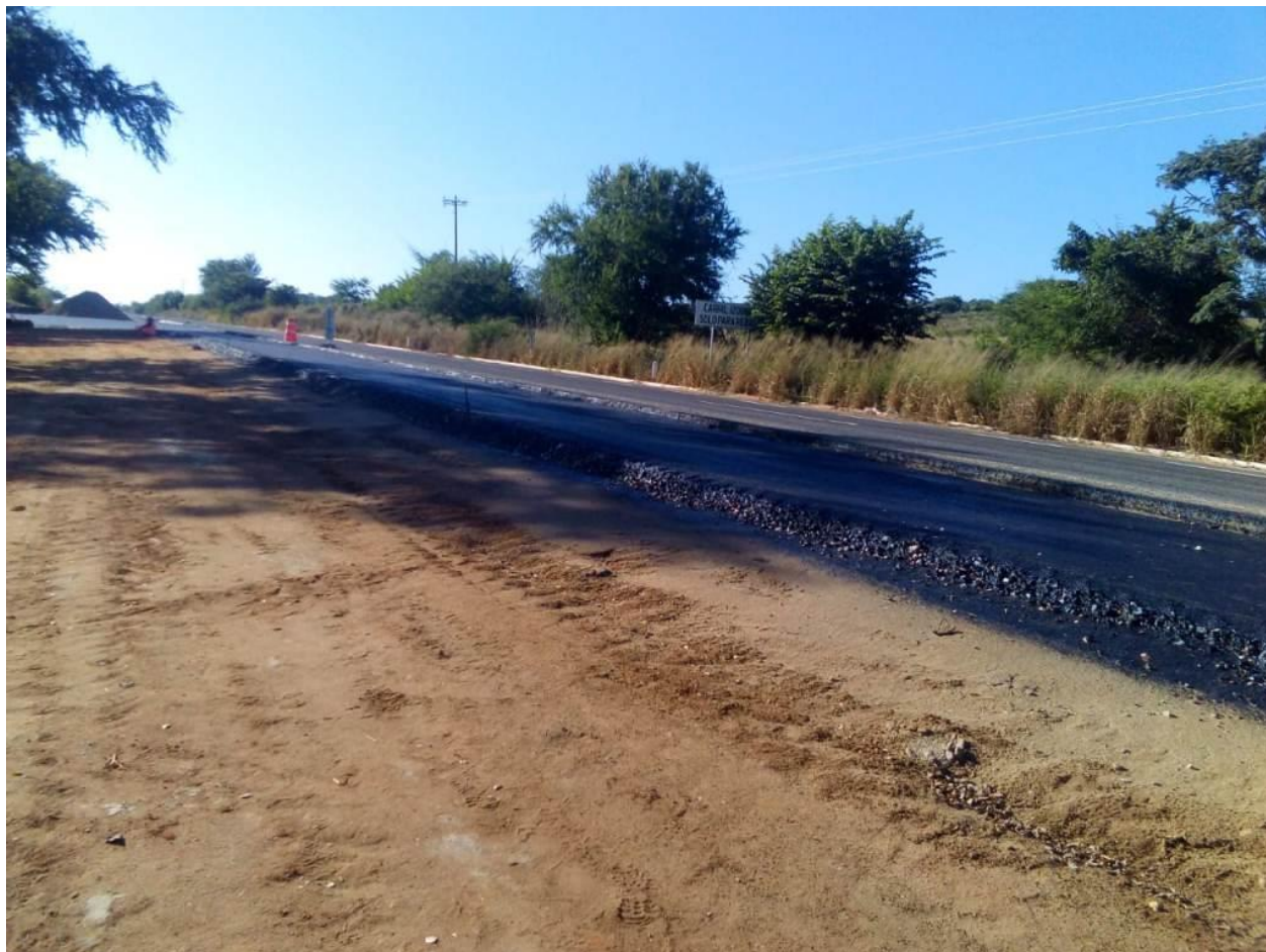
Fotografías 2.- Acceso del predio sobre la Carretera Federal en el que están realizando la ampliación y reencarpetamiento personal de la SCT.
