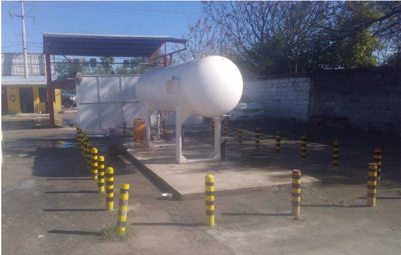
**Foto 3** Tanque de almacenamiento sobre bases de sustentación metálicas y postes de protección contra impacto vehicular.
