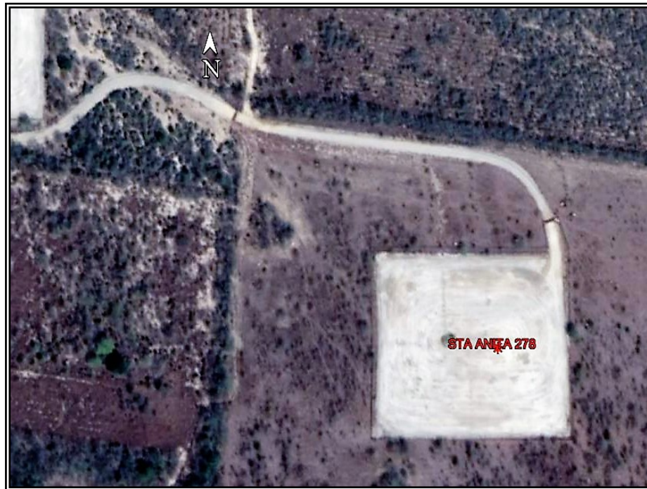
Imagen III.4.6-3.- Vista de la localización donde se llevará a cabo la perforación del pozo correspondiente al camino de acceso y cuadro de maniobras del Pozo Santa Anita 278.
