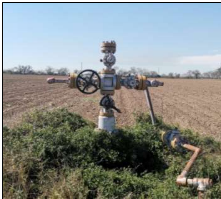
Figura 11. Mantenimiento a conexiones superficiales del Pozo Treviño 405
