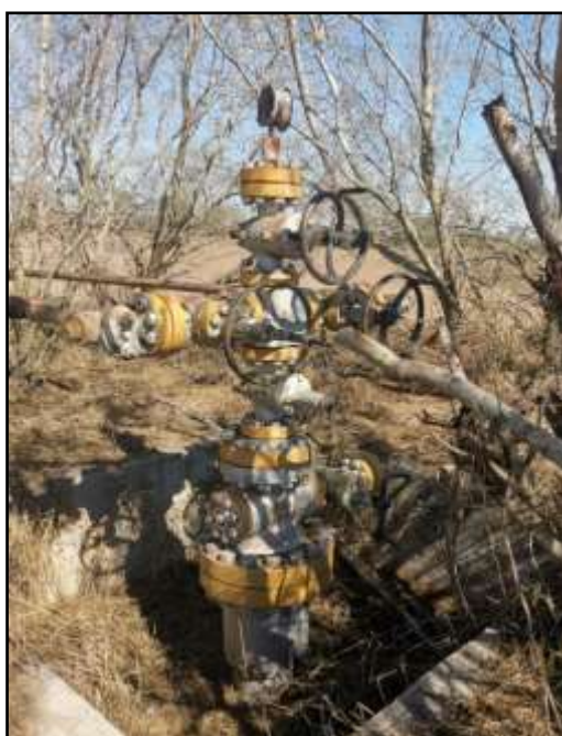
Figura 11. Mantenimiento a conexiones superficiales del Pozo Treviño 217
