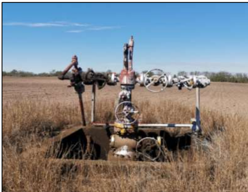
Figura 11. Mantenimiento a conexiones superficiales del Pozo Treviño 109
