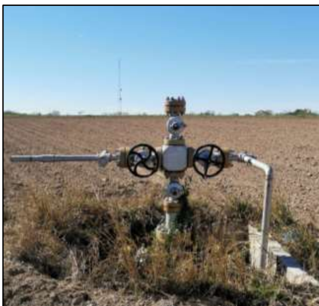
Figura 11. Mantenimiento a conexiones superficiales del Pozo Treviño 421
