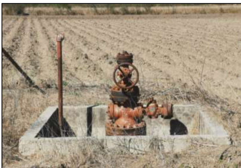
Figura 11. Mantenimiento a conexiones superficiales del Pozo Treviño 117
