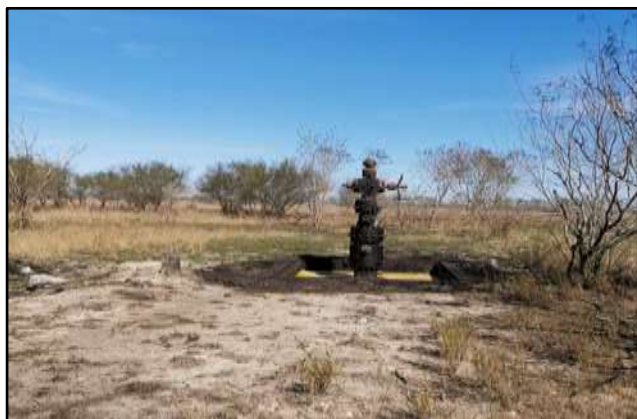
Figura 24. Descripción del área del pozo Niquel 1
