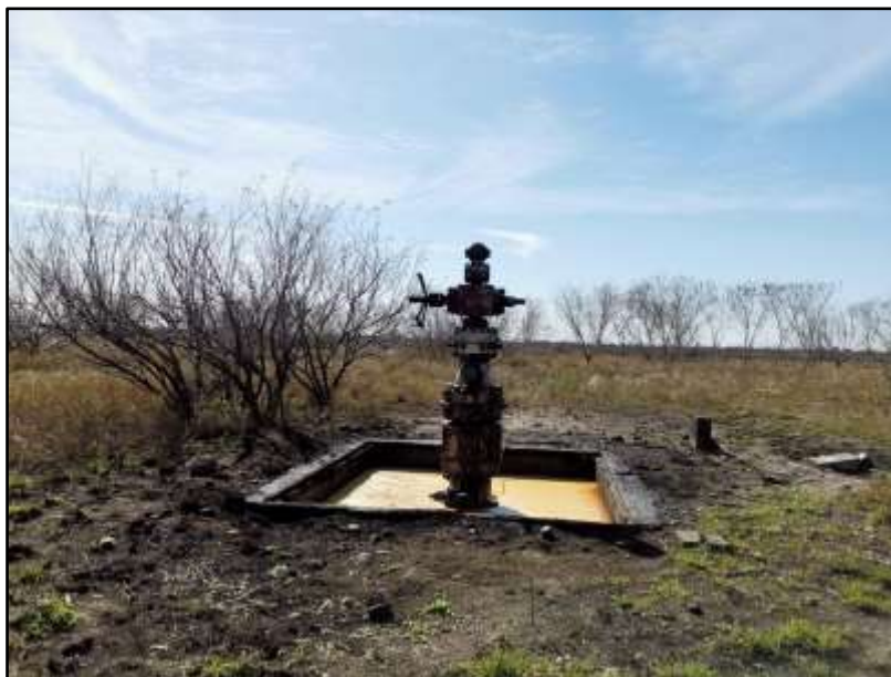
Figura 11. Mantenimiento a conexiones superficiales del Pozo Niquel 1
