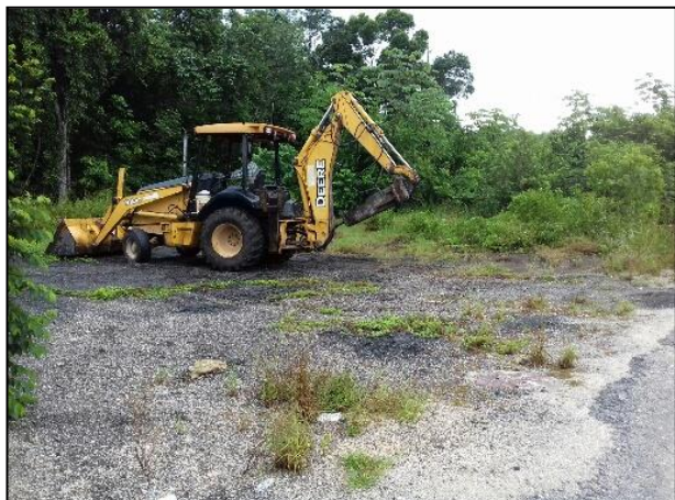
1.- Con apoyo de la retroexcavadora se acondicionó el terreno para la construcción de la celda provisional.
