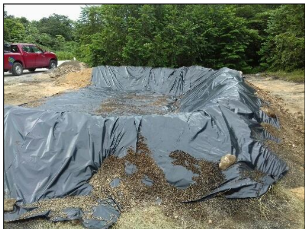
3.- La celda provisional se cubrió con una película de polietileno de alta densidad.
