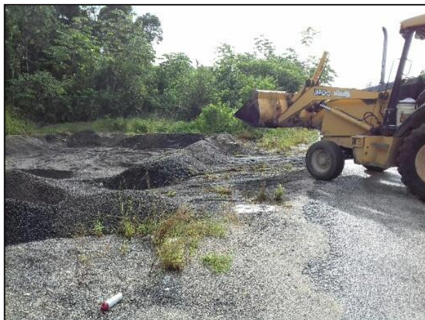
2.- Se construyeron los bordos de la celda provisional.
