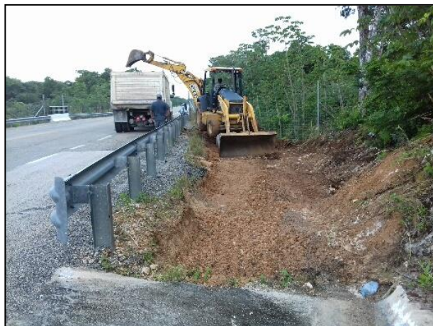
6.- Acarreo del material edáfico dañado hacia la celda provisional.
