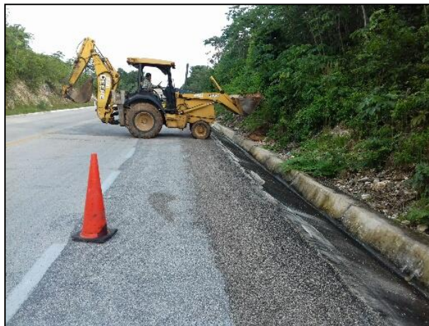
8.- Con apoyo de la retroexcavadora se extrajo el material edáfico afectado de la loma.
