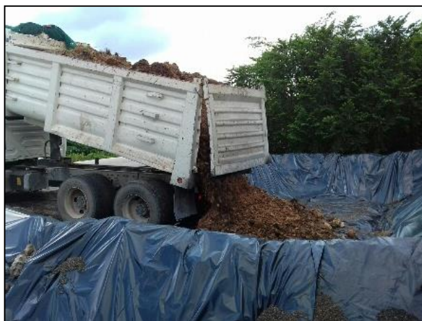
10.- Depósito del material edáfico afectado en la celda provisional.
