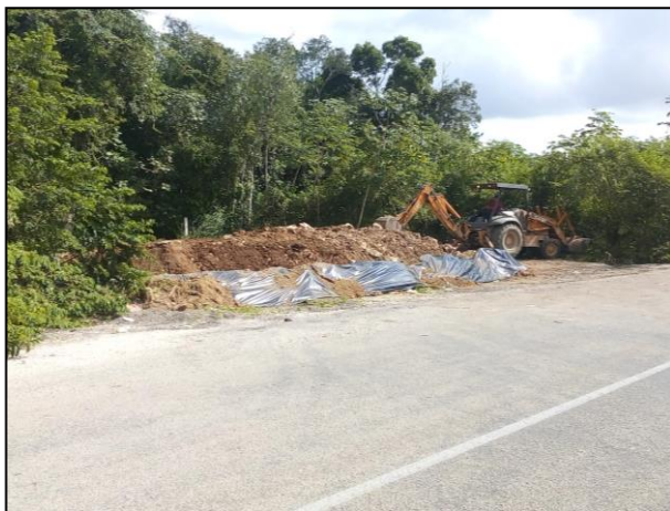
11.- Se logró la extracción exitosa del material edáfico afectado.
