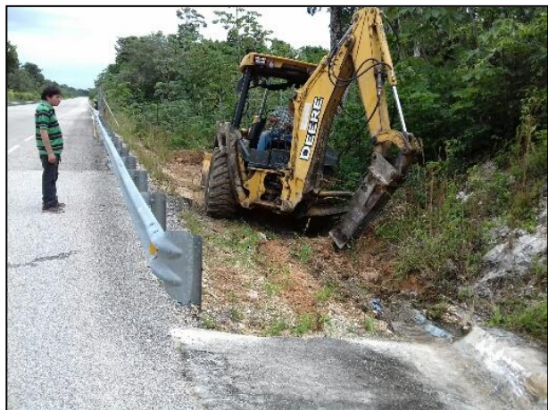
5.- Con ayuda de martillo hidráulico se perforó el suelo para su extracción, ya que presenta abundante roca caliza.
