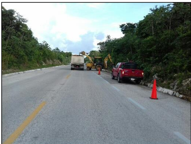
9.- Acarreo del material edáfico afectado hacia la celda provisional.
