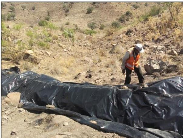
5. La barrera de contención fue cubierta con una película de polietileno de alta densidad
