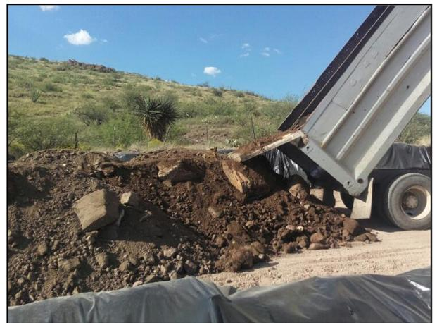
16. Depósito del material edáfico extraído en la celda provisional.
