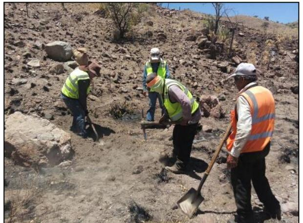
4. Construcción de barrera de contención, compuesta de material edáfico libre de contaminantes.
