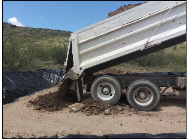
12. Depósito del material edáfico afectado en la celda provisional.
