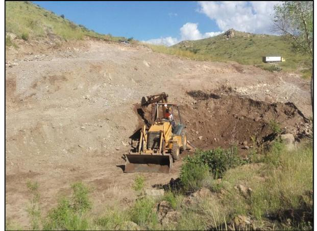
14. Con ayuda de retroexcavadora, se realizó la extracción del material edáfico afectado.
