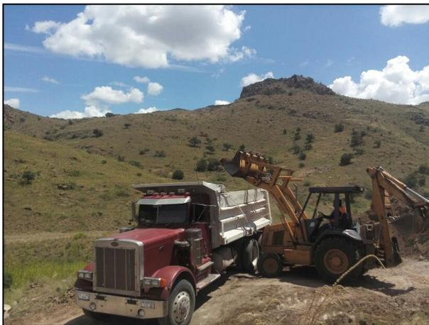
15. Acarreo del material edáfico afectado hacia la celda provisional
