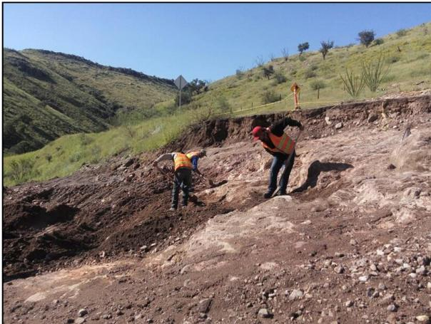
9. Con ayuda de recurso humano equipado con palas se realizó un raspado superficial en la zona para retirar cualquier remanente de la sustancia derramada, aunado a la presencia de rocas de diferentes tamaños.
