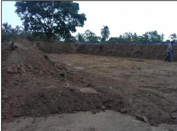
9 – Construcción de los bordos de contención de la celda provisional.
