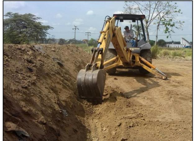
10 – Construcción de canaletas para la captación de lixiviados de la celda provisional con ayuda de la retroexcavadora.
