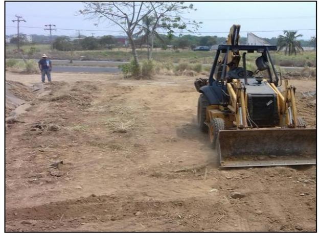
14 – Compactación de la capa de arcilla con apoyo de maquinaria pesada como lo es la retroexcavadora.
