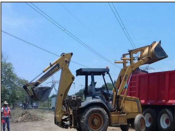
17 – Acarreo de material edáfico afectado proveniente de la fosa de excavación, desazolvió de cuneta de concreto y de la limpieza del arroyo innominado, para su posterior deposito en celda provisional.
