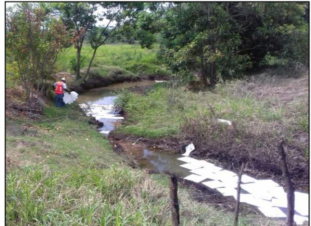
2 – Para evitar el desplazamiento del contaminante en fase libre, se colocó material absorbente.
