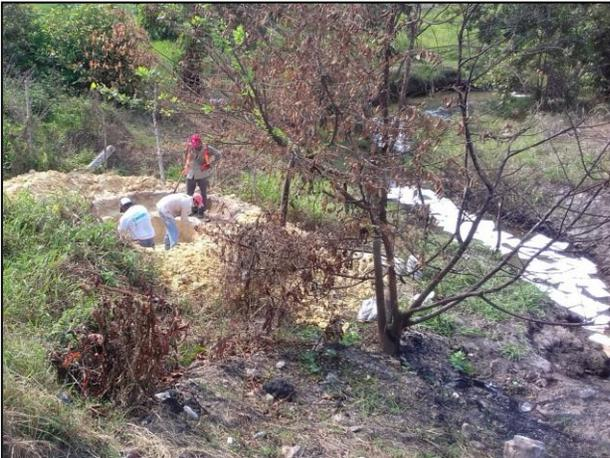
3 – Construcción de celda temporal para depositar el material extraído derivado de la limpieza de la ribera del arroyo innominado y posteriormente acarrearlo a celda provisional.
