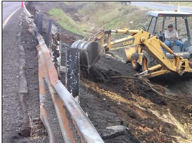
15 – Extracción de material afectado con hidrocarburo (Turbosina) con apoyo de maquinaria pesada.
