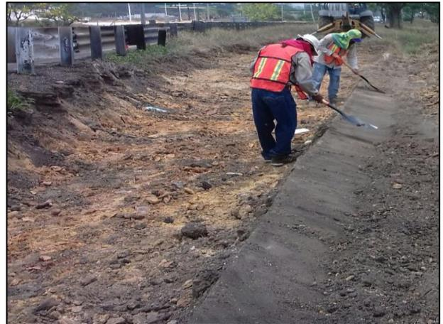
16 – Con apoyo de recurso humano equipado con palas se desazolvió la cuneta de concreto del dren pluvial, retirando material edáfico afectado.
