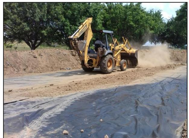
12 – Se colocó una capa de arcilla sobre la película de polietileno de alta densidad para aumentar la impermeabilidad de la celda provisional.
