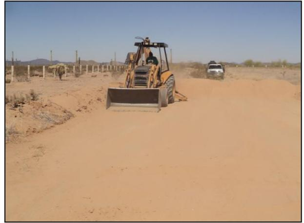
2.- Construcción de bordos de la celda provisional con ayuda de la retroexcavadora.
