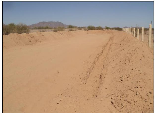
4.- Construcción de bordos y canaletas de captación de lixiviados.
