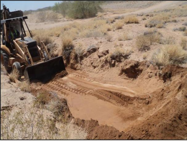
7.- Extracción del material edáfico afectado con Diésel con apoyo de la retroexcavadora.
