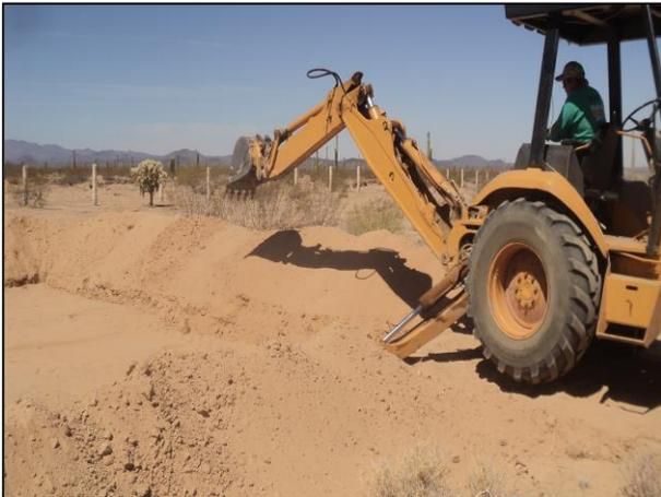
3.- Construcción de canaletas de captación de lixiviados de la celda provisional con ayuda de la retroexcavadora.
