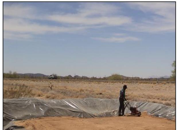
6.- Compactación de la capa de arcilla colocada en la celda provisional, con la ayuda de un vibrocompactador manual.
