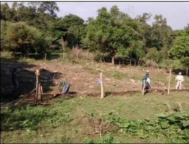
9.- Con apoyo de recurso humano equipado con picos y palas, se construyó la barrera impermeable.
