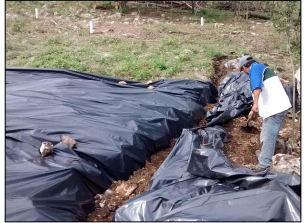
14.- Con apoyo de rocas y material edáfico extraído durante los trabajos de excavación, se reforzó la barrera
