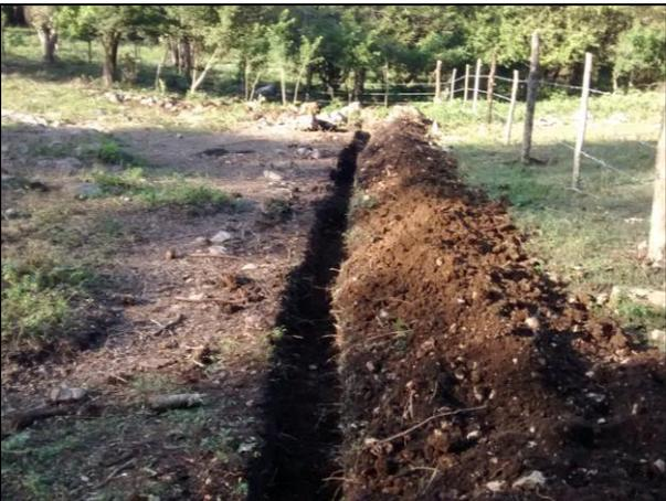
11.- Vista del corte realizado en el suelo afectado con el objetivo de evitar el desplazamiento del hidrocarburo.
