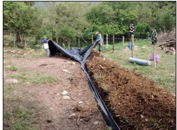
12.- Posteriormente con apoyo de recurso humano, se extendió una película de polietileno de alta densidad sobre el corte realizado.
