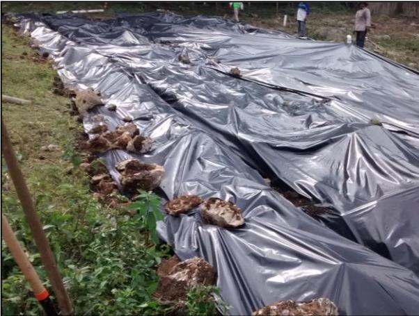
15.- Se colocaron soportes alrededor de la barrera impermeable para evitar que fuera removida por el viento.
