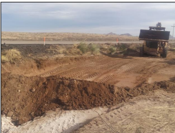
11.- Extracción de material afectado perteneciente al derecho de vía.
