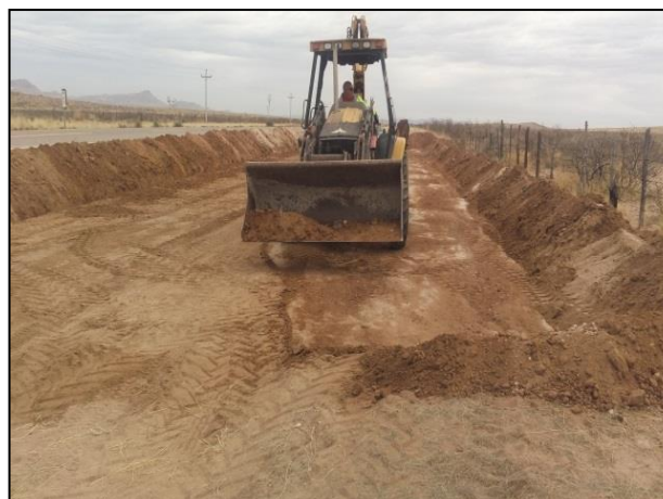
4.- Construcción de los bordos de la celda.
