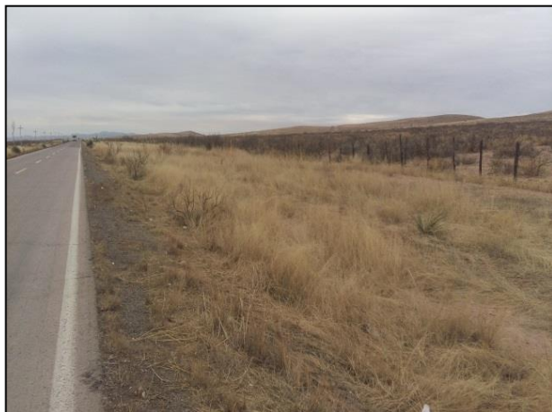
1.- Ubicación del sitio de impacto, en el Km. 022 + 100 (1120) Janos – Agua Prieta, tramo Janos – El Valle, Municipio de Janos, Estado de Chihuahua.
