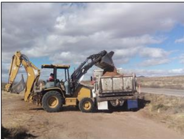
17.- En un camión volteo se transportó el material edáfico contaminado con Diésel, hasta la celda provisional.
