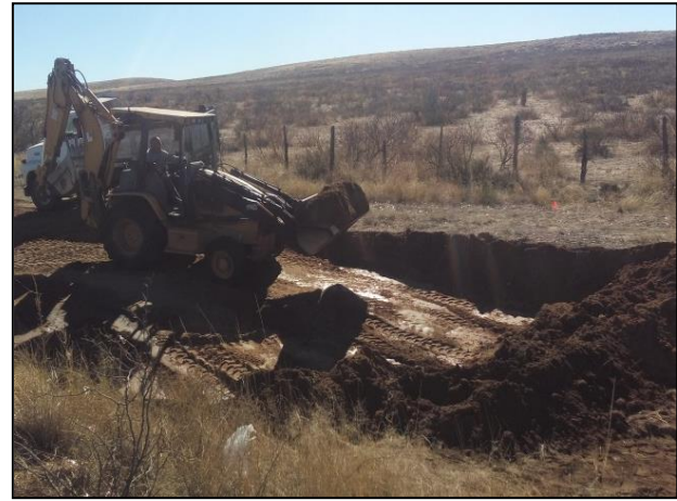
10.- Con ayuda de maquinaria pesada, se llevó a cabo la extracción del material edáfico contaminado con Diésel.
