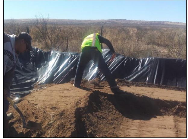
8.- Se agregó una capa de arcilla para aumentar la impermeabilidad de la celda.
