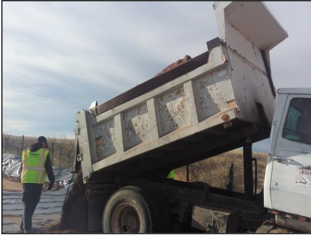
7.- Se agregó una capa de arcilla sobre la película de polietileno de alta densidad para aumentar la impermeabilidad de la celda.
