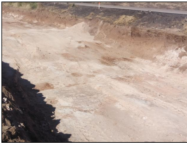
15.- Fosa de Excavación.
