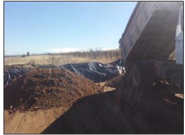
16.- Deposito de material afectado en celda provisional.
