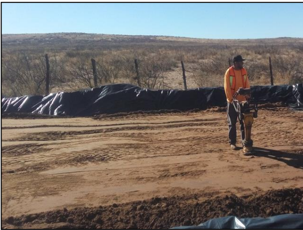
9.- Compactación de la capa de arcilla con ayuda del vibro compactador.
