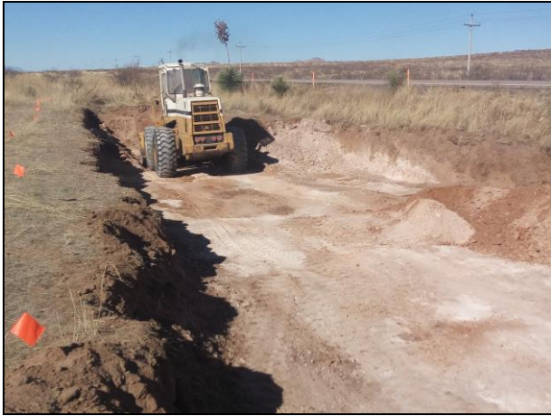
13.- Se realizó la extracción del material afectado con Diésel.
