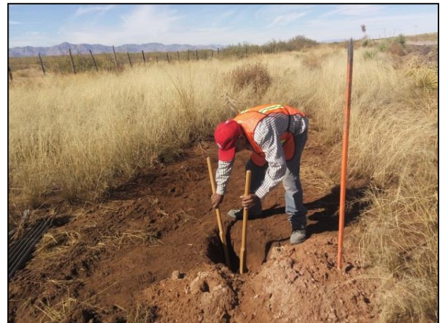
4.- Se realizaron sondeos a diferentes profundidades en suelo afectado.
