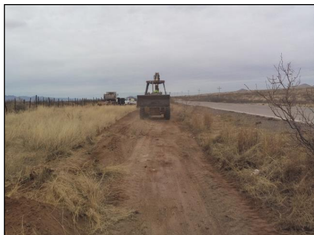
3.- Acondicionamiento del sitio para la construcción de la celda provisional, con ayuda de la retroexcavadora.
