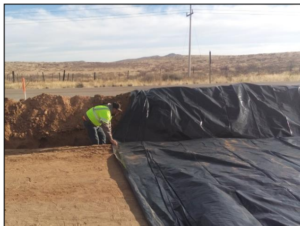
6.- Se colocó una película de polietileno de alta densidad para cubrir la celda y bordos.
