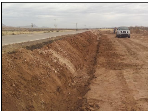
5.- Construcción de la canaleta perimetral para la captación de lixiviados.
