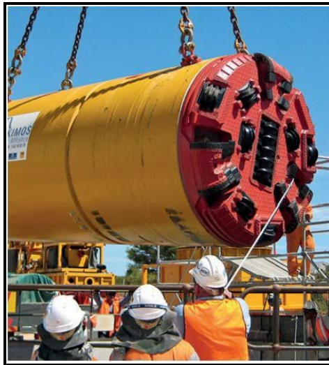
Figura II.34 Instalación de MTBM en pozo de ataque.
