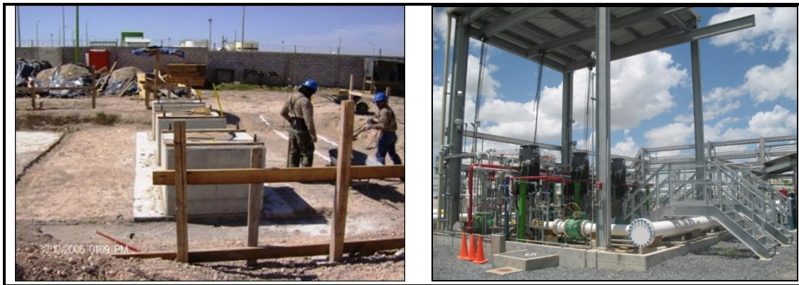
Foto II.5 Ejemplo de cimentación y pedestales para montaje de bombas.
