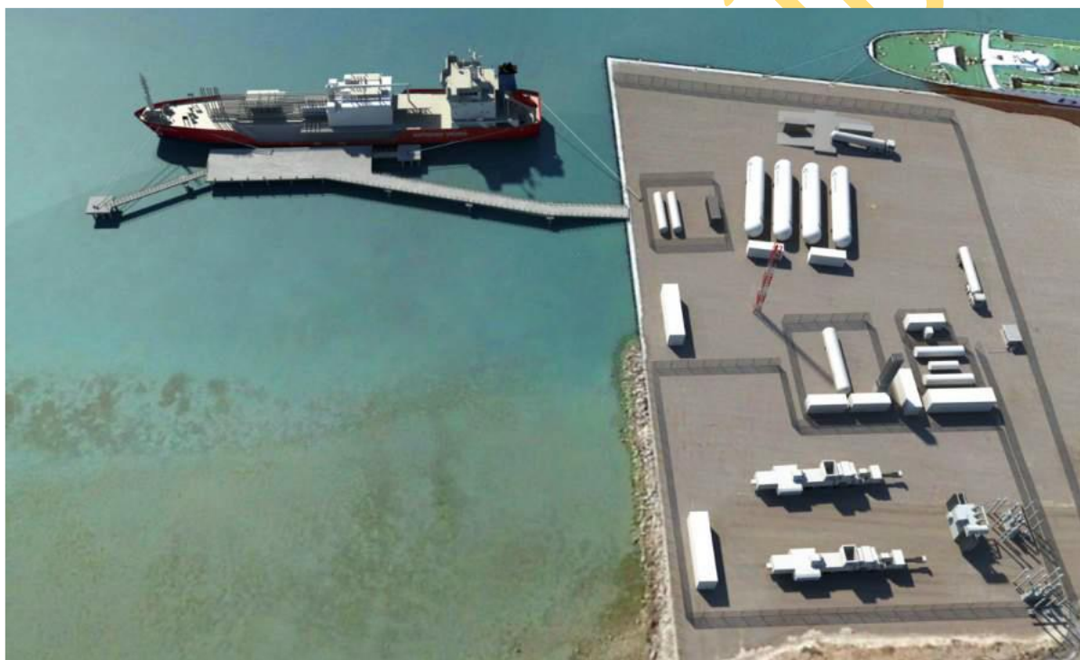
Figura II.6.- Microterminal de Gas Natural.
