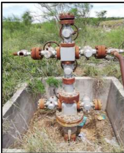
Figura 10. Mantenimiento a conexiones superficiales
