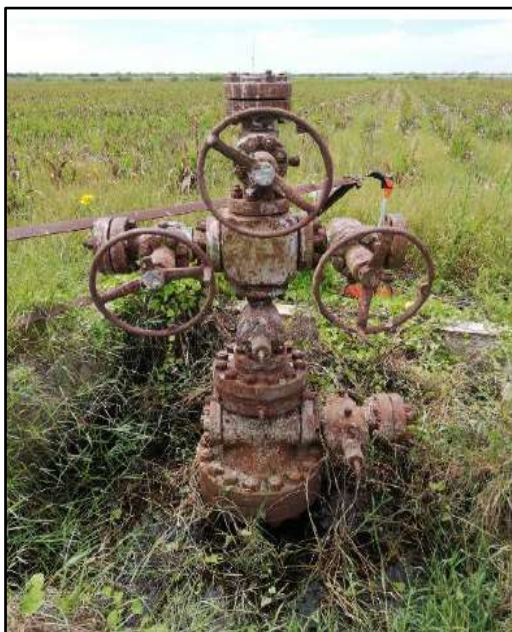
Figura 9. Mantenimiento a conexiones superficiales
