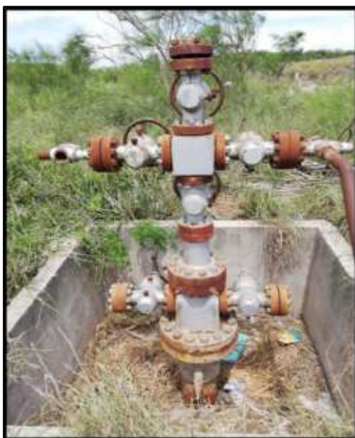
Figura 12. Mantenimiento a conexiones superficiales
