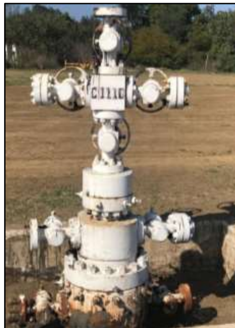
Figura 10. Mantenimiento a conexiones superficiales
