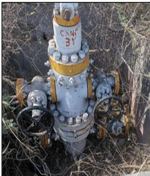
Figura 11. Mantenimiento a Conexiones Superficiales
