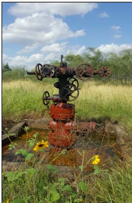
Figura 11. Mantenimiento a conexiones superficiales
