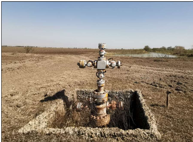
Figura 11. Mantenimiento a conexiones superficiales del Pozo Treviño 122
