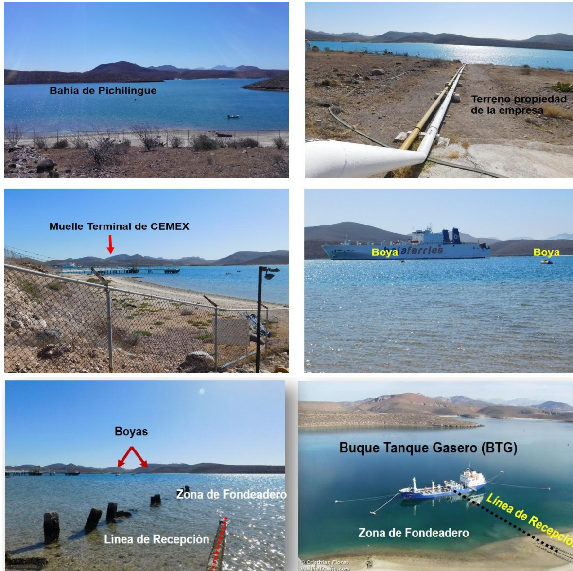
Figura V.2.3. Superficie marina 30,118.37 m 2 : la zona marina no será intervenida principalmente porque la infraestructura marina está en su totalidad instalada, la empresa DIEGAS, S.A. de C.V., dispone de un fondeadero de amarre a cuatro puntos (4 boyas de sujeción), cabe mencionar que esta superficie se encuentra impactada con anterioridad en virtud de que es utilizada como canal de navegación para el acceso a los muelles del Puerto de Pichilingue por embarcaciones de pasaje y carga
