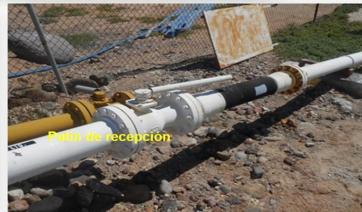
Figura V.2.5. La línea de recepción tiene un diámetro de 6" con clasificación ASME para manejo de gas en medio marino y protección catódica e inicia en el punto de descarga del BTG y termina en el patín de recepción, en su extremo terminal marino se conecta a una manguera de neopreno especial para GLP con una longitud de 30 m y 6" de diámetro.
