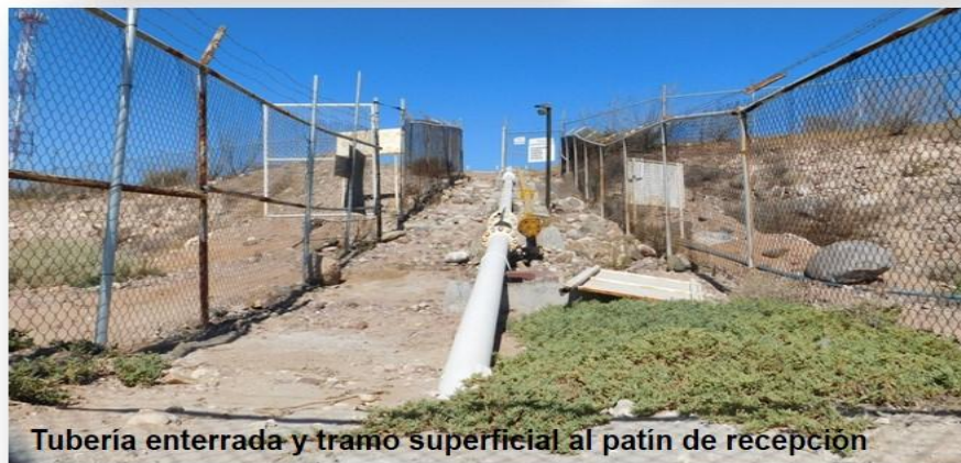
Figura V.2.5. La línea de recepción tiene un diámetro de 6" con clasificación ASME para manejo de gas en medio marino y protección catódica e inicia en el punto de descarga del BTG y termina en el patín de recepción, en su extremo terminal marino se conecta a una manguera de neopreno especial para GLP con una longitud de 30 m y 6" de diámetro.
