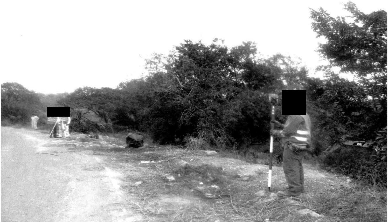
Figura 10. Levantamiento topográfico con estación total
