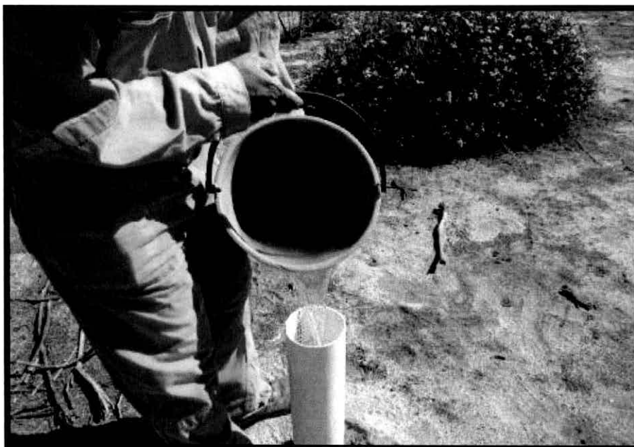
Construcción del pozo para la prueba de conductividad.
