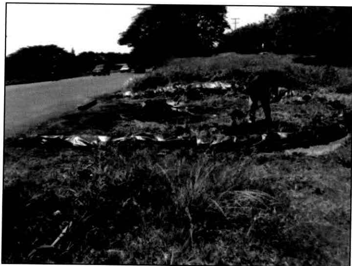
3. La barrera de contención se construyó con material edáfico de la zona (libre de contaminantes).
