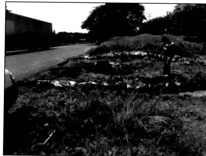
4. La barrera de contención se cubrió con una película de polietileno de alta densidad.
