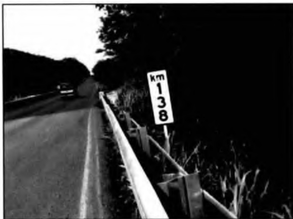
Punto de impacto, a la altura del Km. 138+000 de la Carretera Federal No. 145-D, Las Choapas-Ocozocoautla
