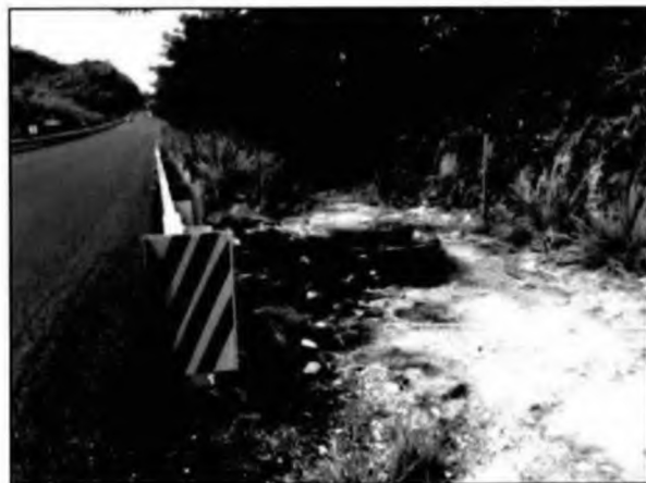
Suelo natural impactado por el derrame de Diesel
