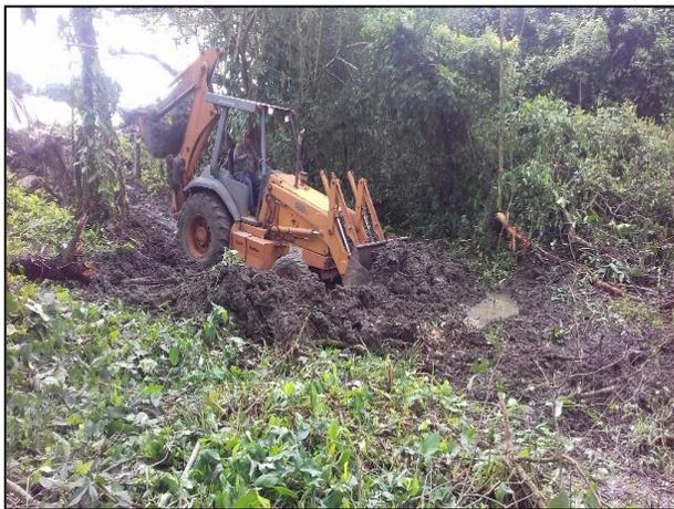
11.- Extracción de material afectado con hidrocarburo (Turbosina) con apoyo de maquinaria pesada.
