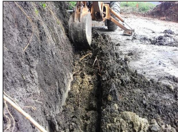
6.- Construcción de canaletas para la captación de lixiviados de la celda provisional con ayuda de la retroexcavadora.
