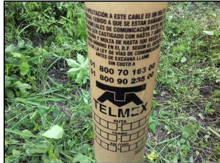
4.- Se observó postería que indica el paso de fibra óptica.
