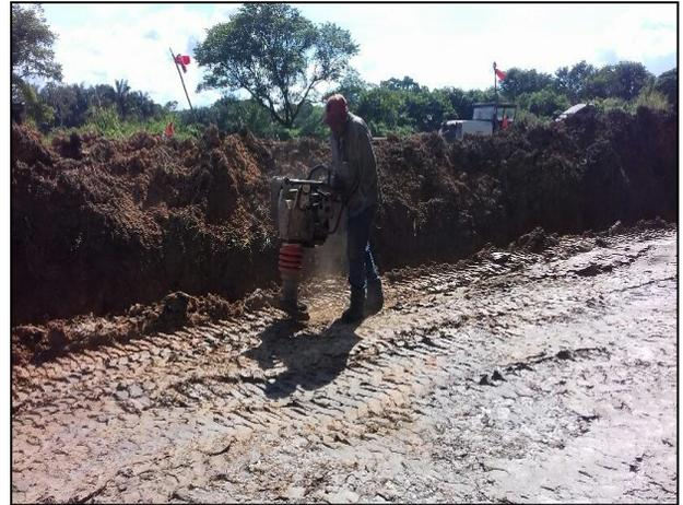
8.- Compactación del suelo de la celda provisional con ayuda de un vibrocompactador manual.
