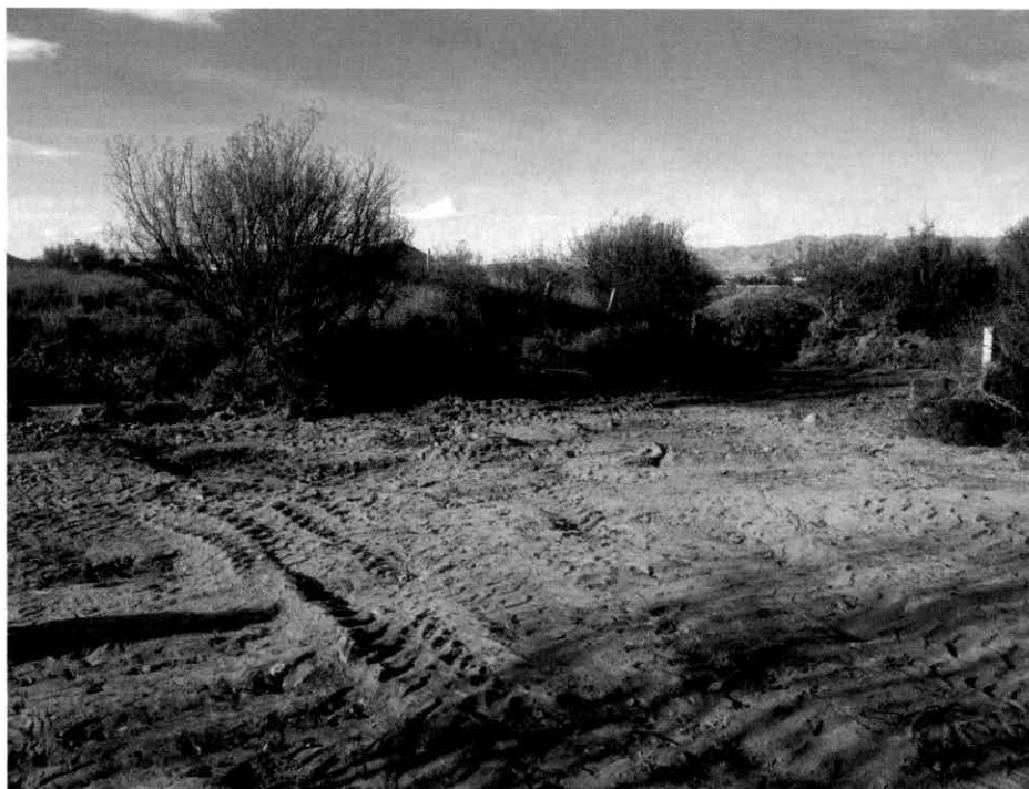
Foto 6. Zona afectada limpia.
