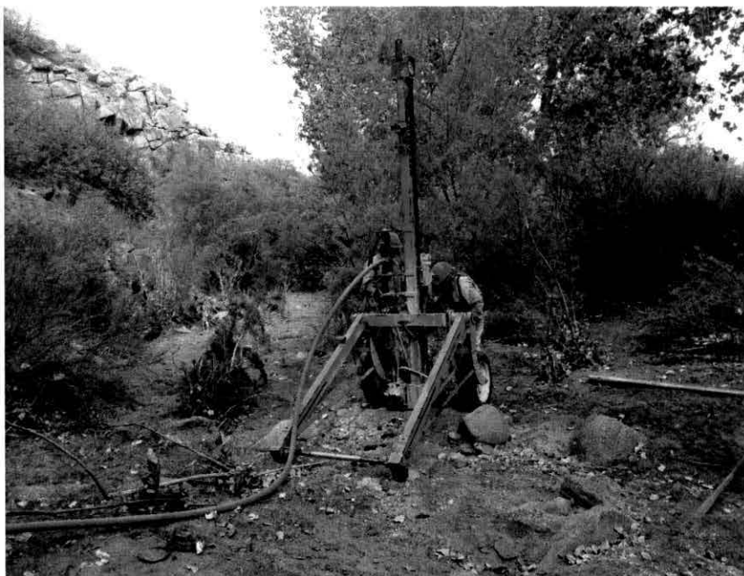
Figura 15. Equipo de perforación rotatorio apoyado mediante compresor de aire.
