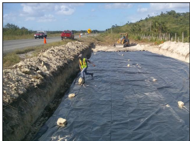
5.- Se cubrió la celda provisional con una película de polietileno de alta densidad.
