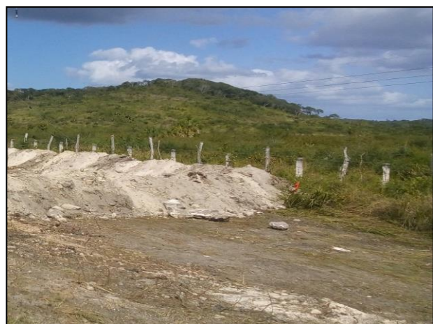
3.- Construcción de bordos de la celda provisional con ayuda de la retroexcavadora.
