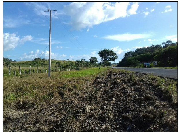
4.- En los alrededores de la zona afectada se encuentra postería de CFE con cableado eléctrico.
