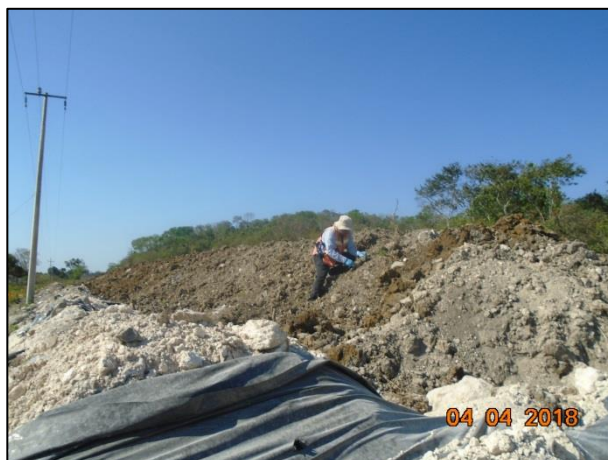
5 – Las muestras superficiales se tomaron con ayuda de una espátula de acero inoxidable. Toma de muestras en la celda provisional
