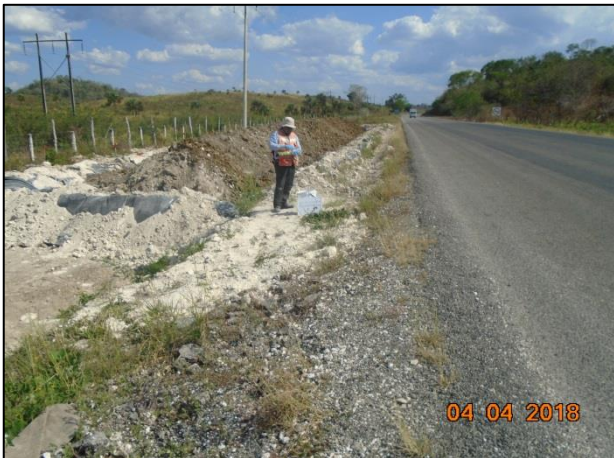
7 – Se tomaron muestras en la periferia de la fosa de excavación a diferentes profundidades.
