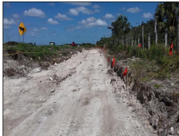
12.- La fosa de excavación se rellenó con material edáfico libre de contaminantes y se colocaron tubos de monitoreo.
