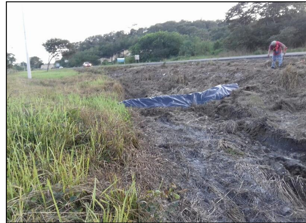
2.- Identificando el desplazamiento del hidrocarburo se construyeron bordos de contención. Los bordos de contención fueron cubiertos con una película de polietileno
