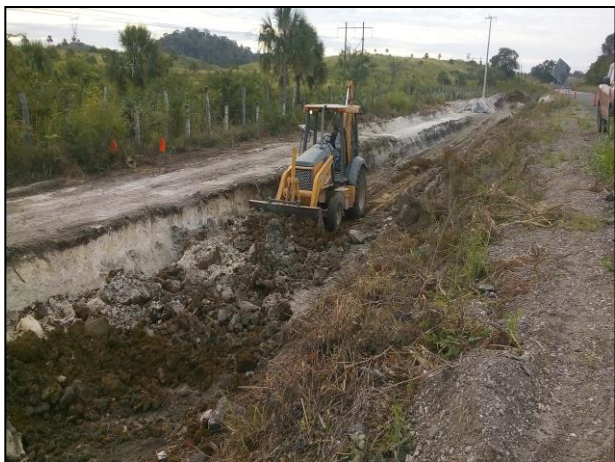
9.- Extracción del material edáfico afectado con Diésel con apoyo de la retroexcavadora.
