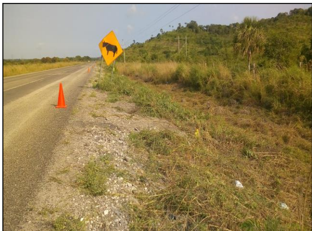
1.- Se colocó señalización preventiva en el sitio en estudio.
