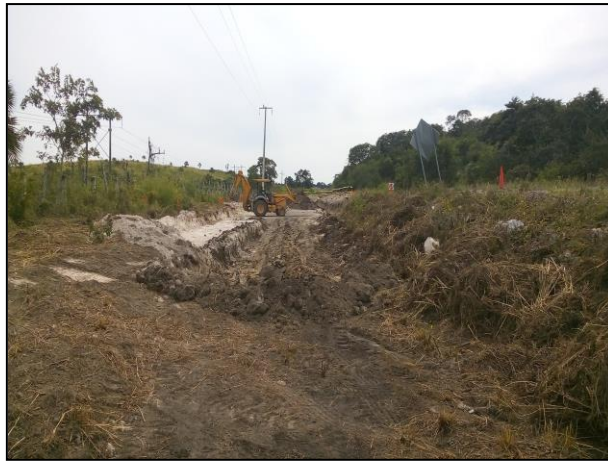
10.- Acarreo de material edáfico afectado a celda provisional con apoyo de retroexcavadora.
