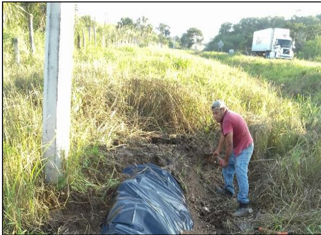
1.- Identificando el desplazamiento del hidrocarburo se construyeron bordos de contención con apoyo de recurso humano.
