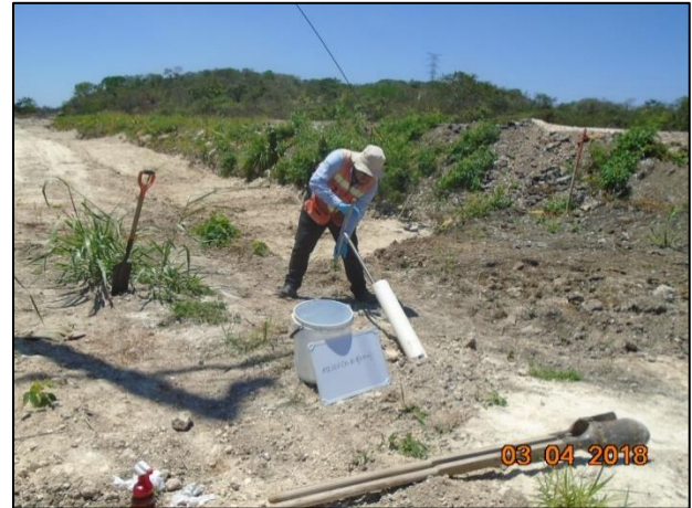
2 – Se tomaron muestras en la pared de la fosa de excavación con apoyo del Hand Auger.
