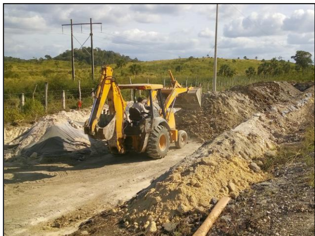
11.- Deposito de material edáfico afectado en celda provisional con la ayuda de retroexcavadora.
