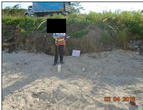
3 – Se tomaron muestras en el fondo de la fosa de excavación.
