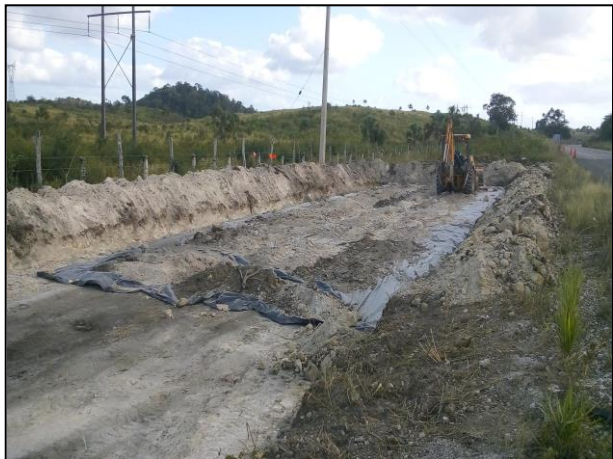
7.- Se colocó una capa de arcilla, misma que fue compactada con de maquinaria pesada.
