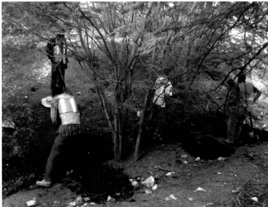
Foto 4. Depósito del suelo afectado en las bioceldas de tratamiento.
