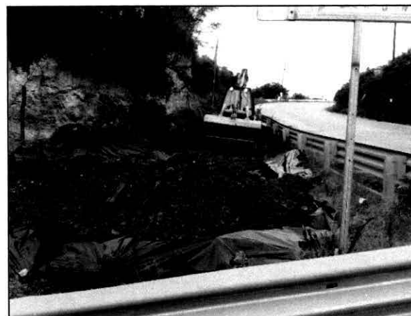
Con apoyo de maquinaria pesada se realizaron las labores de emergencia
