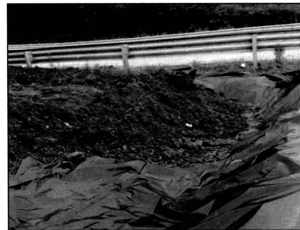
Vista de la celda provisional con el material edáfico impactado con Diesel
