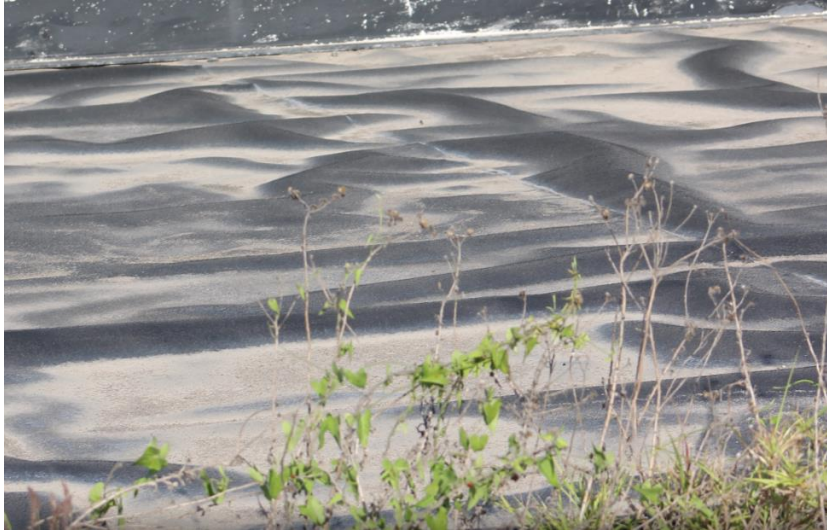
Fotografía 10 Geomembrana de polietileno.
