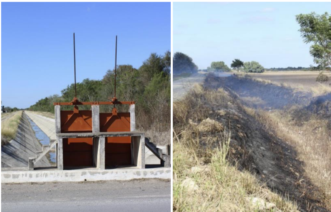
Figura 91 Canal revestido y de tierra usado para el riego dentro de la zona de estudio.
