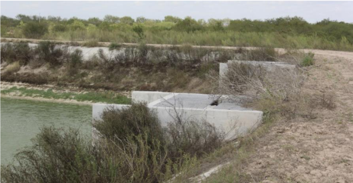
Figura 92 Planta de tratamiento de aguas residuales El Vergel.
