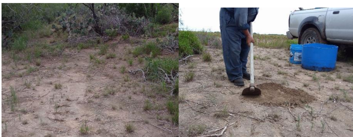
Figura 50 Preparación del sitio para la prueba de infiltración número 5.
