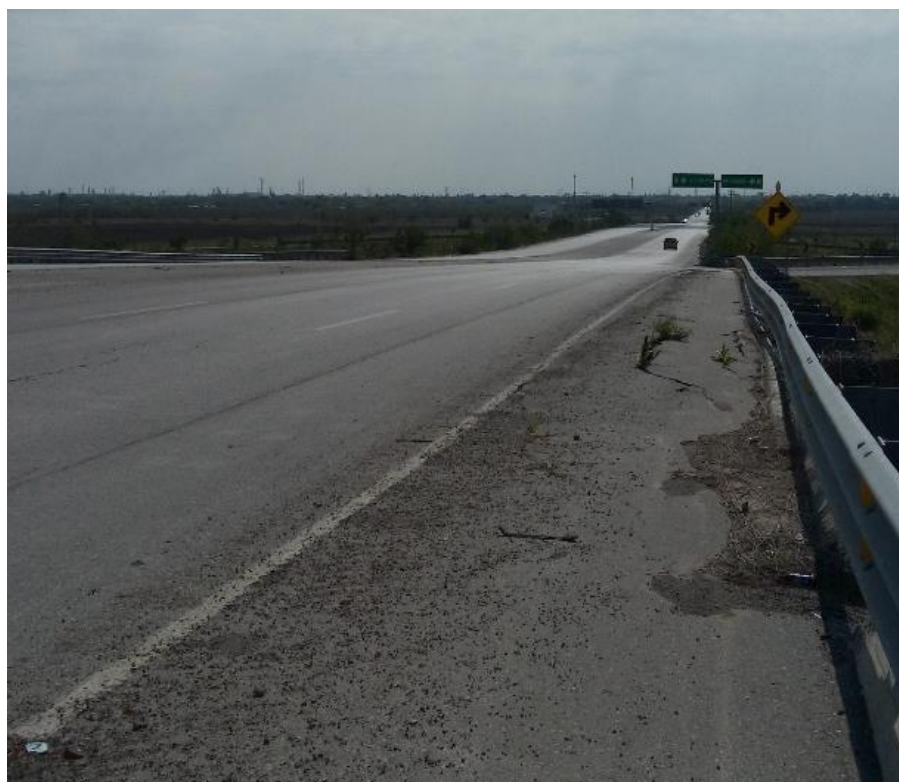
Figura 77 Autopista federal de cuota N° 2.
