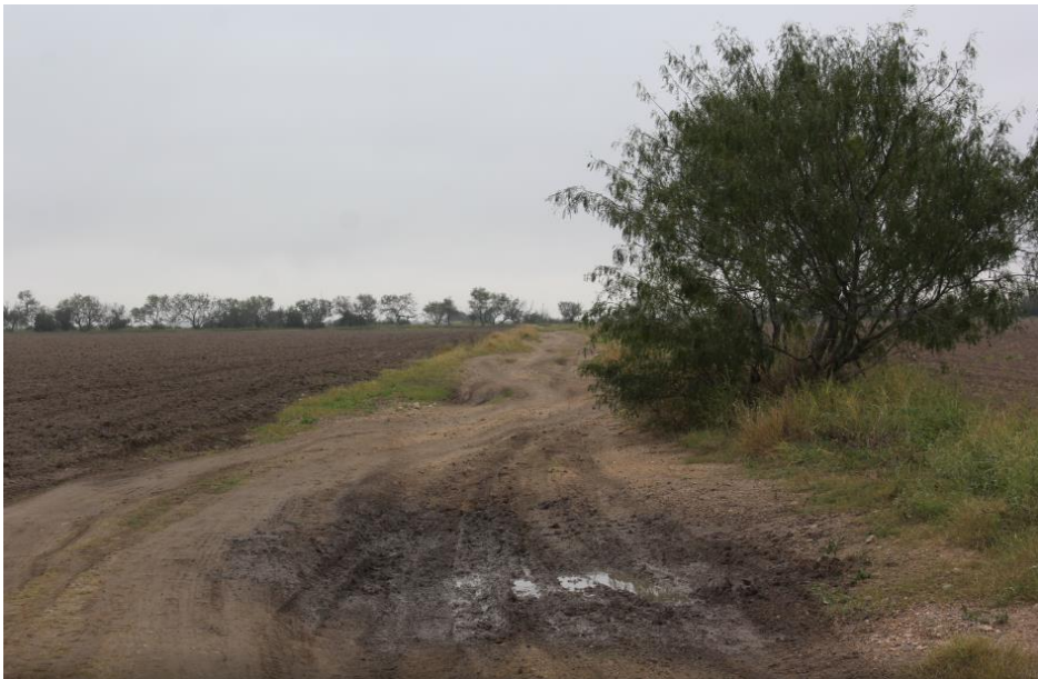
Fotografía 32 El camino existente necesita rehabilitarse.
