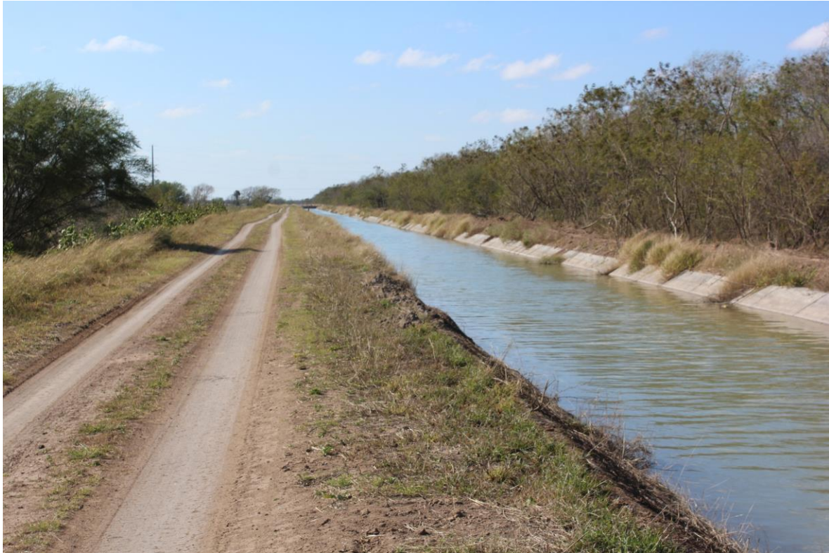
Fotografía 20 Cruce de canal pavimentado y camino de terracería Coordenadas UTM X: 603815.00Y: 2872525.3
