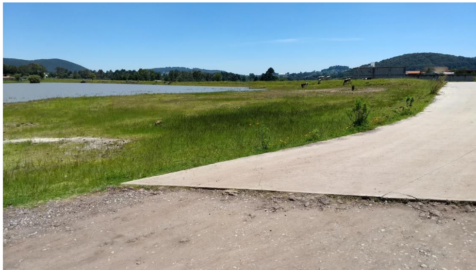
Fotografía 5. Camino de concreto parcial
