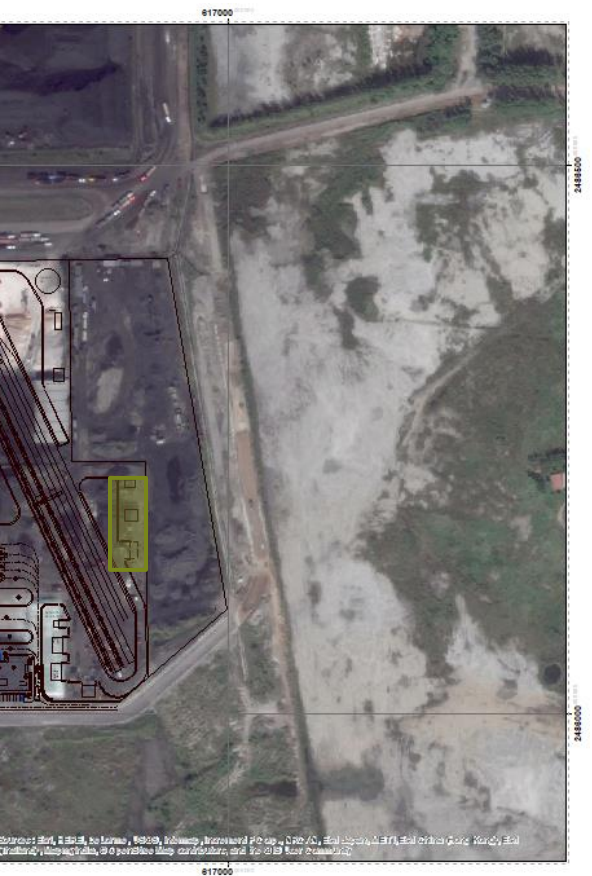
posos, planta de tratamiento de aguas residuales y fosa API.
