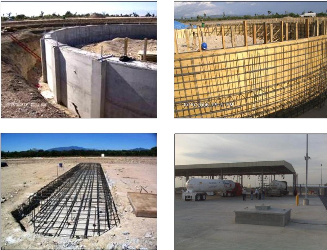
**Figura 2.5.** Ejemplo de infraestructura de cimentación para tanques de almacenamiento y patines de carga de autotanques.
