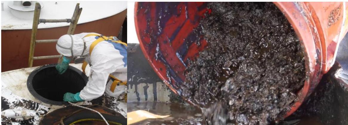
**Figura 6.11.** Ejemplo de limpieza de tanques de almacenamiento de combustible.
